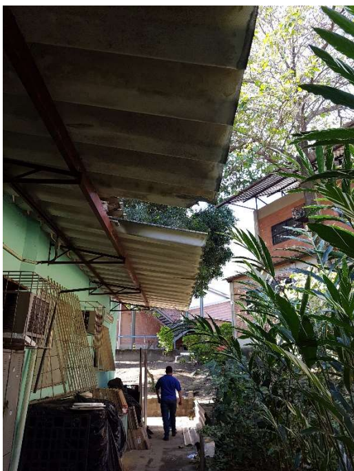
Figura 21 – Telhas danificadas em consequência do vão excessivo do balanço
