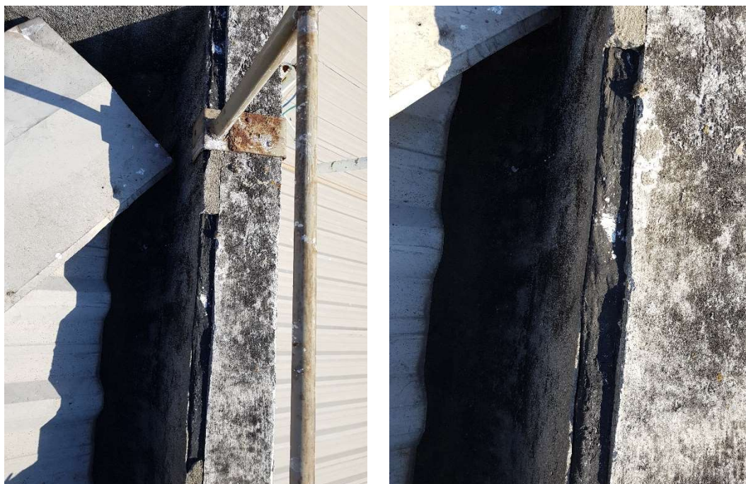
Figura 13 – Canto laje e mureta com proteção mecânica deteriorada e manta asfáltica incompleta.
