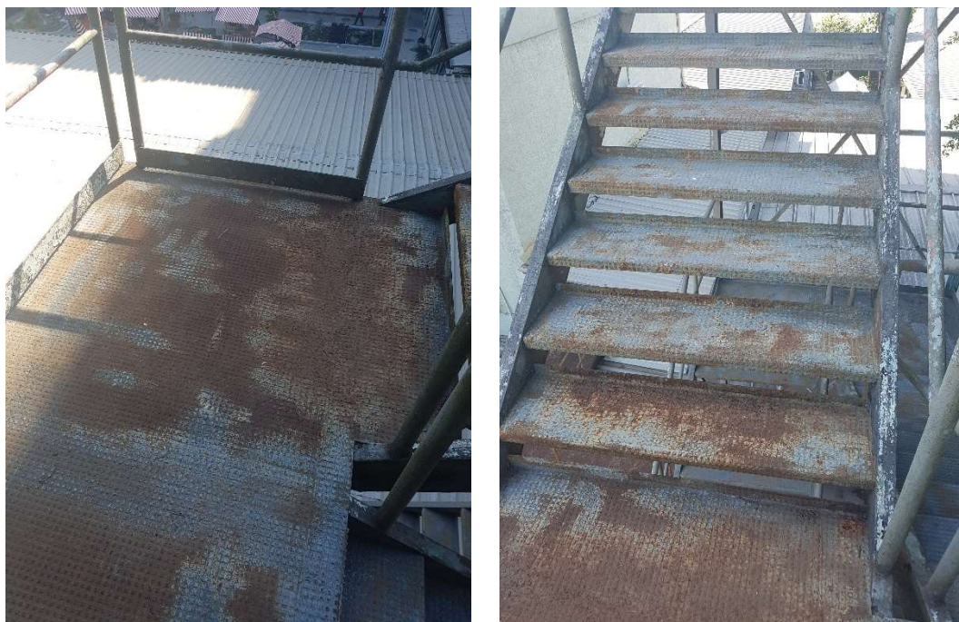
Figura 5 – Patamares com corrosão, idem figura 4, sendo que os últimos patamares possuem maiores áreas corroídas por acumular maiores poças de água em relação aos patamares inferiores.
