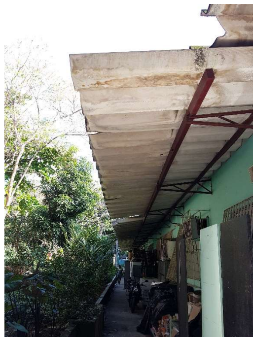
Figura 21 – Telhas danificadas em consequência do vão excessivo do balanço
