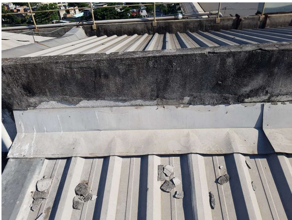
Figura 12 – Rufo amassado e com falhas na estanqueidade.
