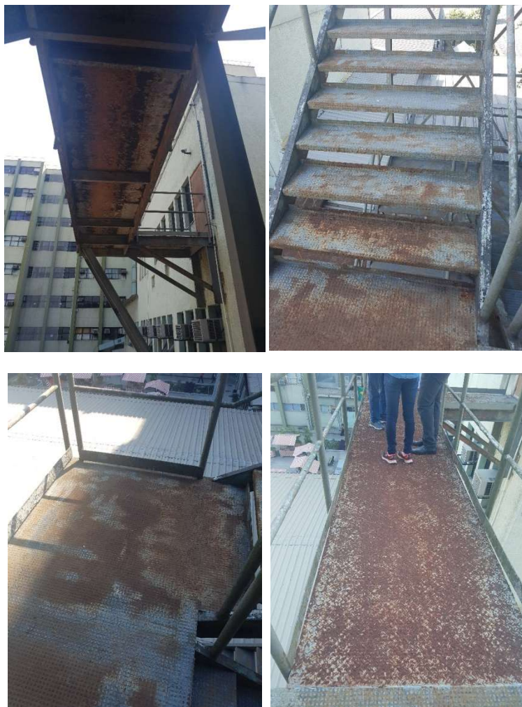
Figura 14 – Corrosão em pisos e patamares
