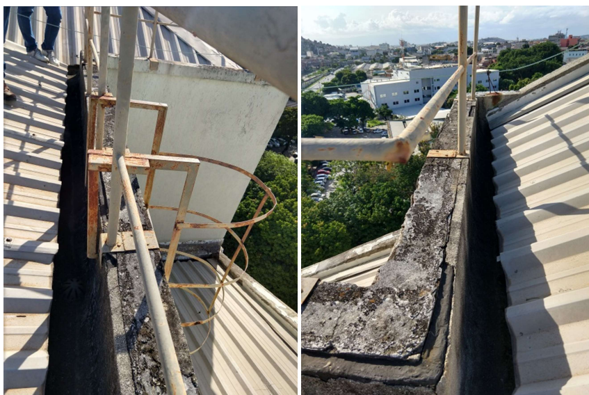
Figura 9 – Manta aplicada de forma inadequada não fazendo a dobra sobre o topo da canaleta. Ocorrendo a quebra da proteção mecânica (como foi o caso) a passagem da água entre a interface manta alvenaria/revestimento é inevitável.
