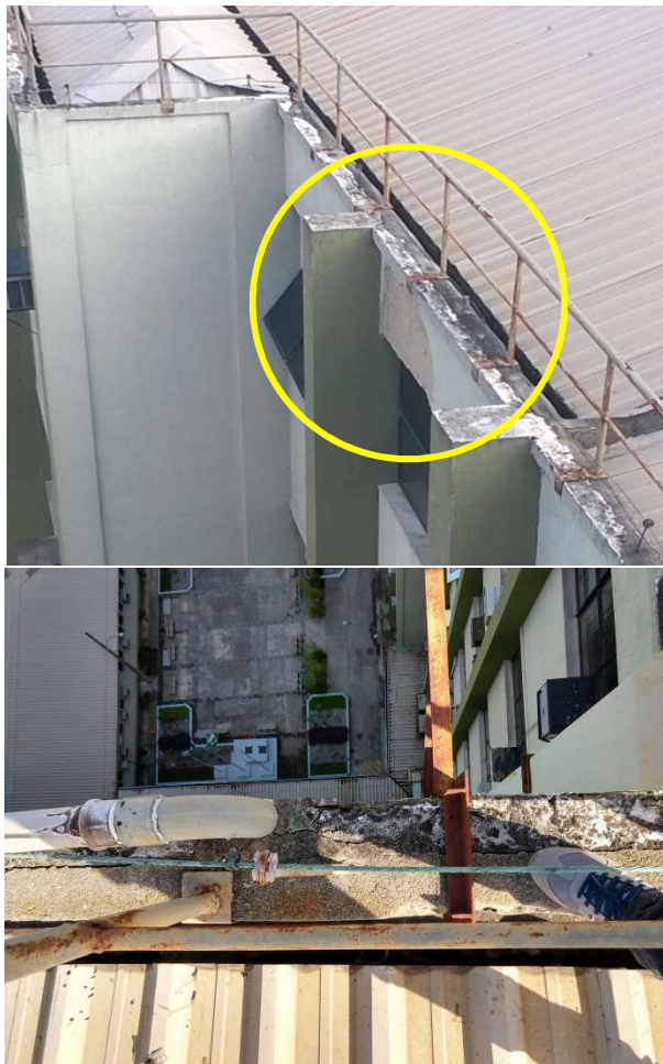
Figura 7 – Ausência de chapim na platibanda. Facilidade de penetração da água no revestimento causando umidade e posteriormente, soltura do substrato.
