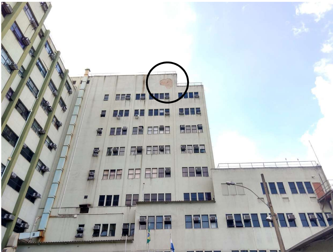
Figura 3 – Descolamento do substrato (argamassa de revestimento). Desplacamento com área aproximada de 1,0 m 2 , ocorrido em março de 2018.
