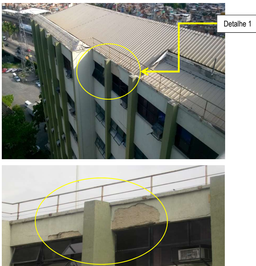
Figura 2 – Descolamento do substrato (argamassa de revestimento).
