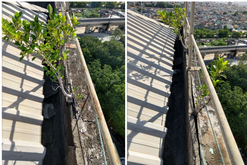
Figura 10 – Manta aplicada de forma inadequada conforme descrito na figura anterior. Permitindo deposição de sementes, entrada de água e crescimento de vegetação na linha do descolamento longitudinal.
