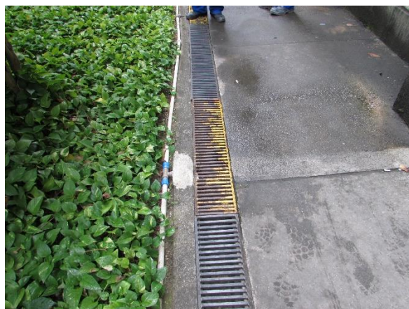
Tubulação de irrigação a ser enterrada
