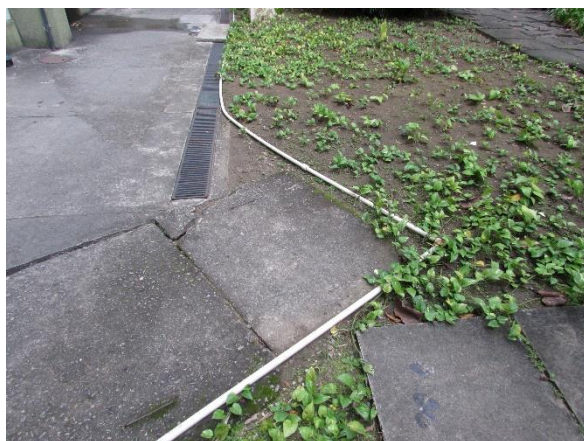
Tubulação de irrigação a ser enterrada
