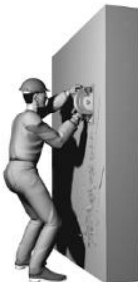
Delimitação da área de reparo com disco de corte.
