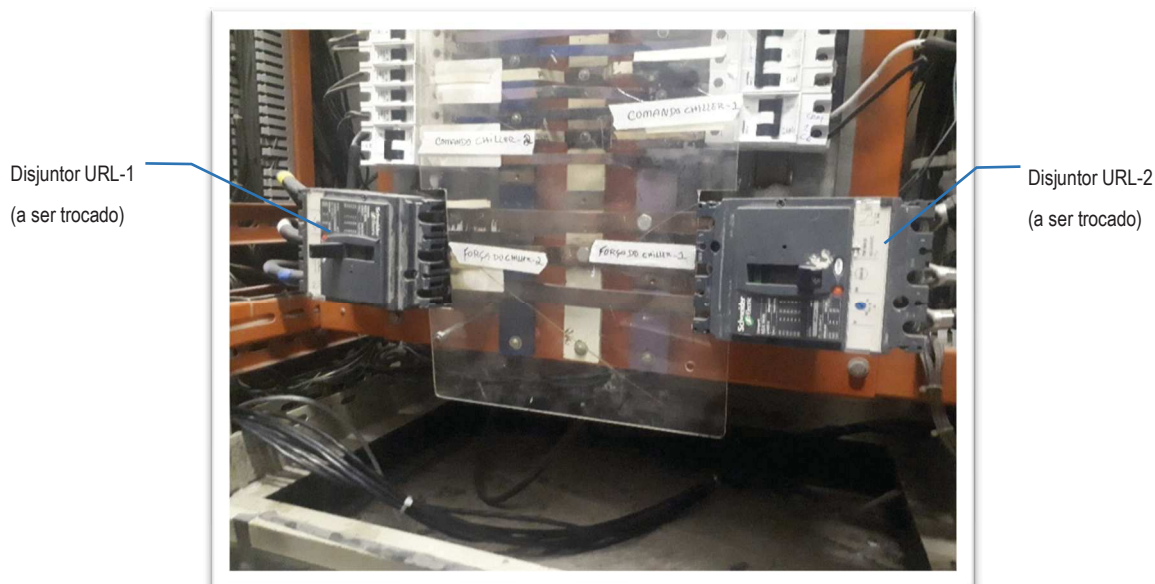
Fig. 5 – QECAG| Substituição dos disjuntores URLs
