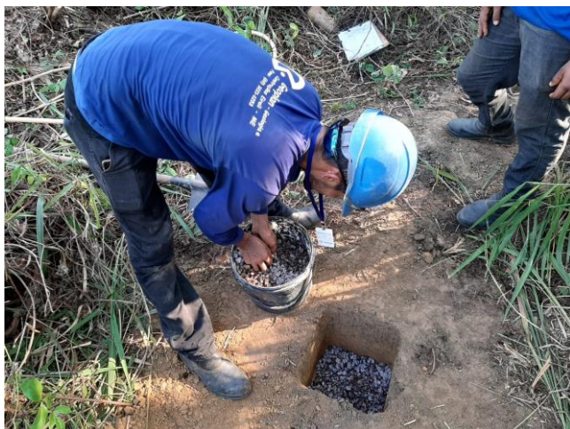
Foto 3 - Camada de 5 cm de brita no fundo do "caixão"
