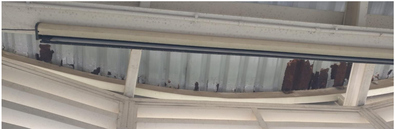
Foto ilustrativa do local – Vista interna corrosão das telhas do Pátio Circular
