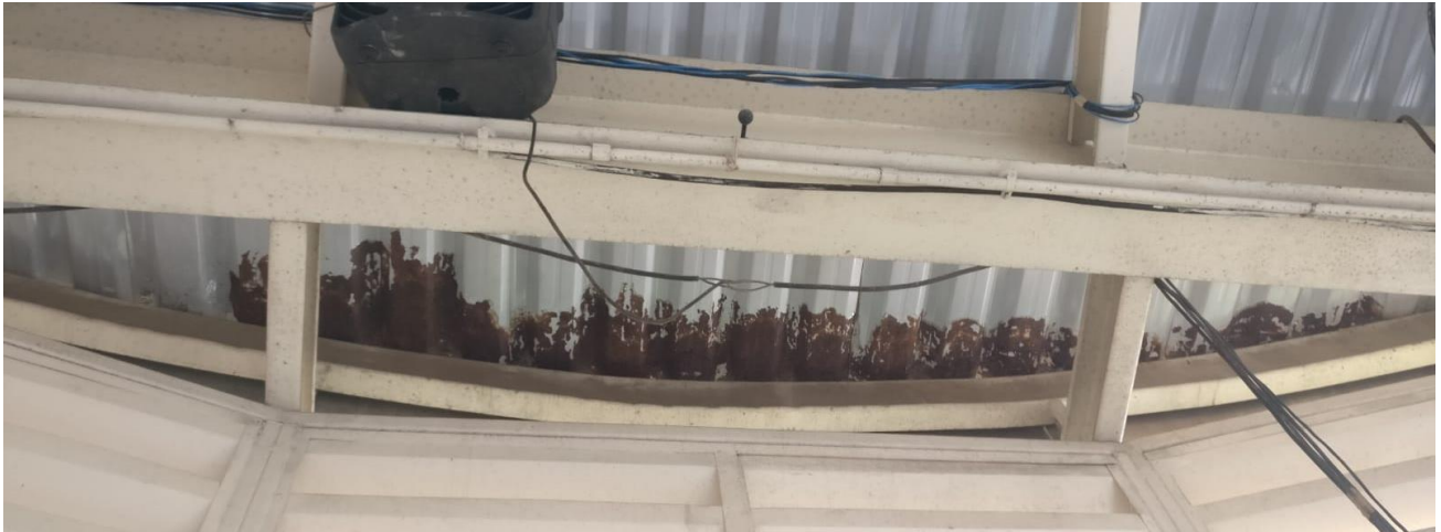
Foto ilustrativa do local – Vista interna corrosão das telhas do Pátio Circular
